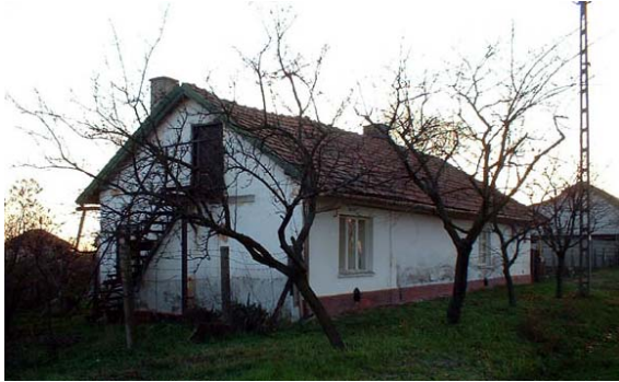
Az egykori vasút állomásépülete hrsz.: 096/3 a major bejáratánál, a kocsmá és a bolt mellett áll. Talán a hagyomány miatt ma is itt áll meg először a Békéscsaba Gyula felől érkező busz.
