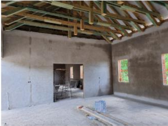
Raktáépület belső vakolás, Inkubátorház bővítés falazás, vb. koszorú készítés
