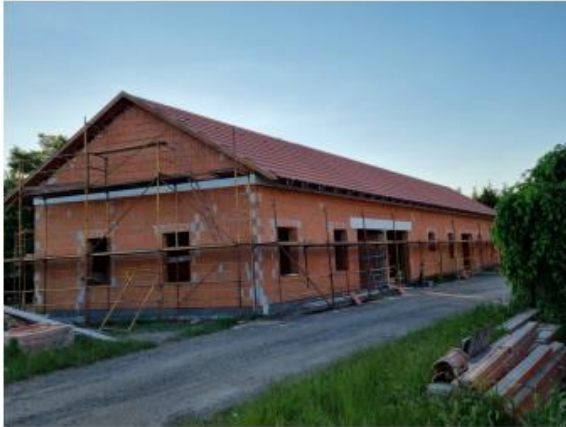
Raktáépület tetőfedés, valamint Inkubátorház bővítés, falazás
