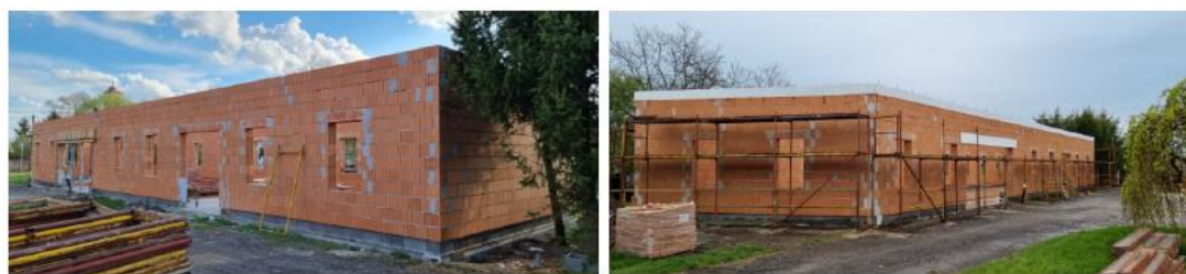
Raktárépült főfalak és vasbeton koszorú
