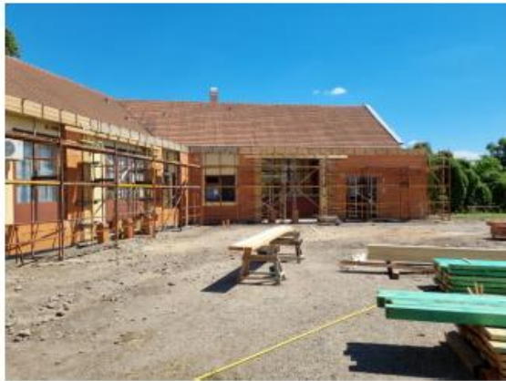
Raktáépület belső vakolás, Inkubátorház bővítés falazás, vb. koszorú készítés
