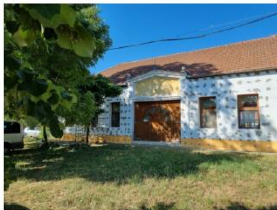
Inkubátorház utcai homlokzati hőszigetelés
