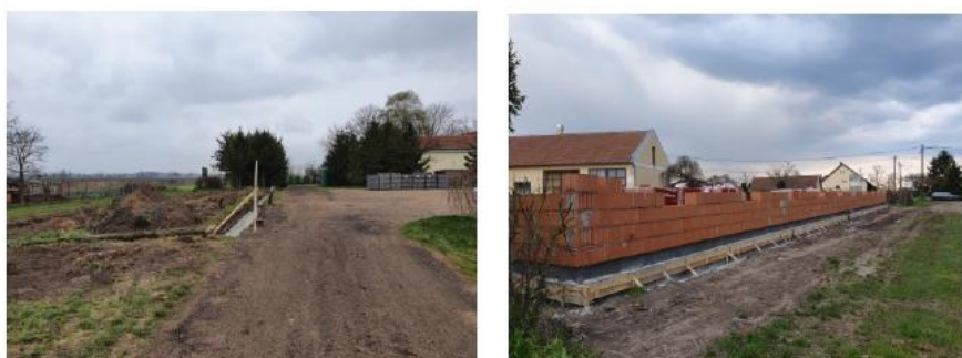
Raktárépület alapozása és falazási munkái
