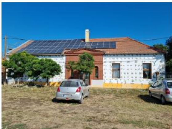
Inkubátorház utcai homlokzati hőszigetelés
