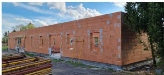
Raktárépült főfalak és vasbeton koszorú
