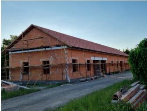
Raktárépület tetőfedés, valamint Inkubátorház bővítés, falazás
