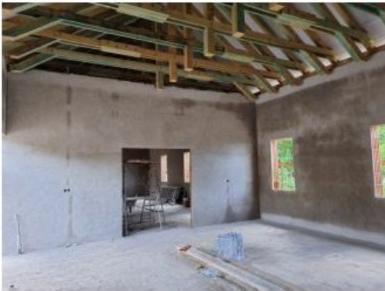
Raktárépület belső vakolás, Inkubátorház bővítés falazás, vb. koszorú készítés
