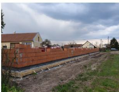
Raktárépület alapozása és falazási munkái
