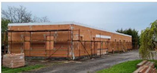
Raktárépült főfalak és vasbeton koszorú
