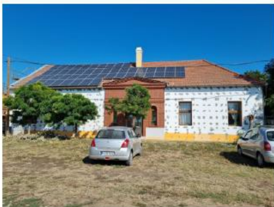
Inkubátorház utcai homlokzati hőszigetelés
