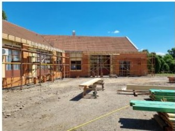
Raktárépület belső vakolás, Inkubátorház bővítés falazás, vb. koszorú készítés
