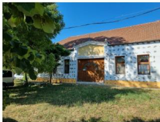
Inkubátorház utcai homlokzati hőszigetelés
