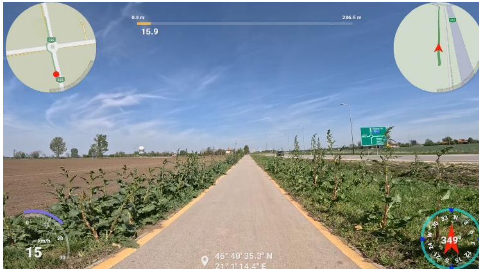
28.sz. kép: Orosházi út 444. sz. II. r. főút 0+016 kmsz
